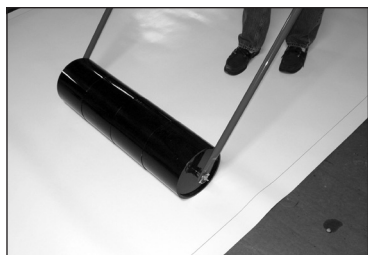
Passage du rouleau de 45 kg (100 lbs) sur la membrane
