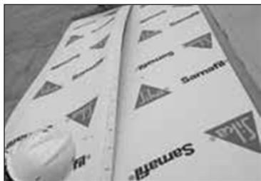
Vapor Retarder SA 31 en position
