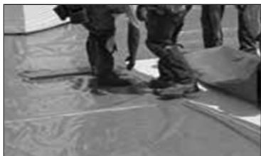
Installation du Sarnavap®-10
