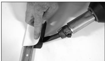
Soudure d'un coussinet de protection
